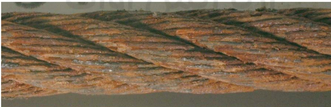
شکل ح ۳- سطح طناب به شدت زنگ زده است-نرخ شدت ٪ ۶۰ متمایل به از رده خارج سازی
