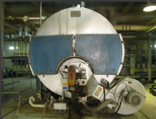
بازرسی فشار روشن و خاموش شدن مشعل دیگ
