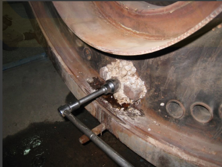
تعویض واشر دریچه های دسترسی
