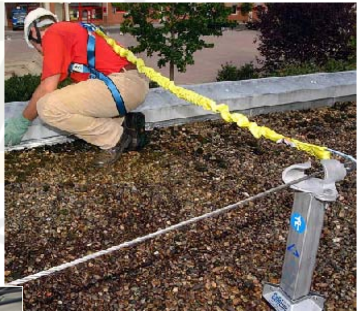
شکل ۵۴-۲- محدود کننده با اتصال یک طناب
